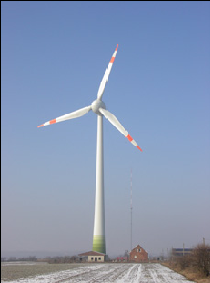
Enercon 4.5MW 112 meter rotor
